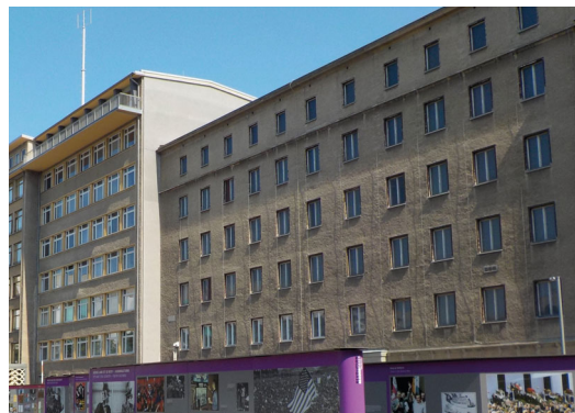
Abb. 5: Haus 7 (Nord), Sanierung
