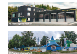
oben: Beispiel Pankower Feuerwache, unten: Zwischennutzung auf dem Feuerwehrstandort 2023
