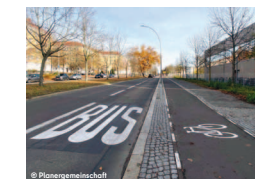
Neue Erschließung Kniprodestraße 2025
