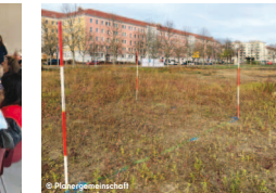
Vorbereitende Bodenarbeiten, Baufläche 2025
