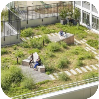
Gründach mit Retention von Regenwasser
