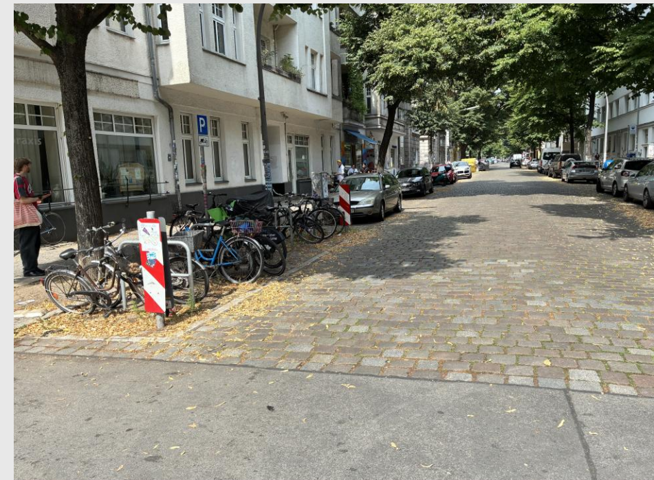
Straßenabschnitt Weser- bis Ossastraße BSG mbH
