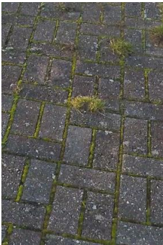
Betonstein rot (Bestand)
