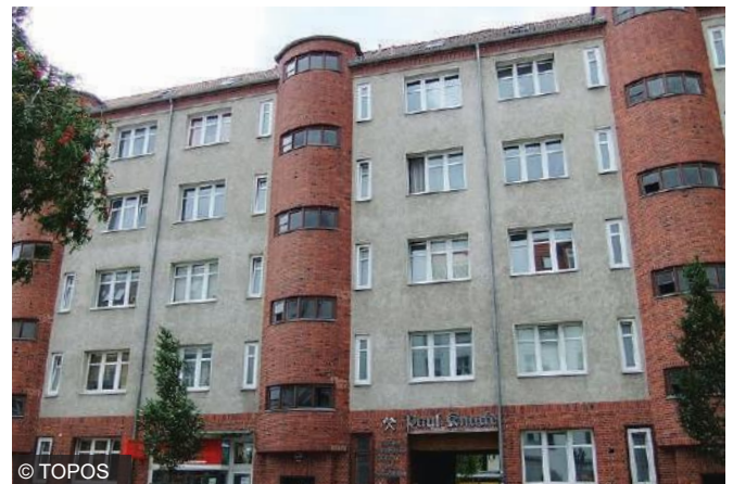
Abb. 05: Baudenkmal einer Wohnhausgruppe
