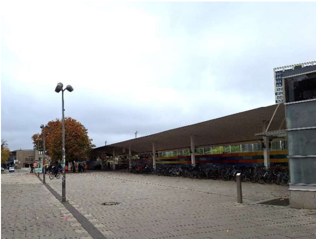
Abbildung 26: Radabstellanlagen am U-Bahnhof Lichtenberg
