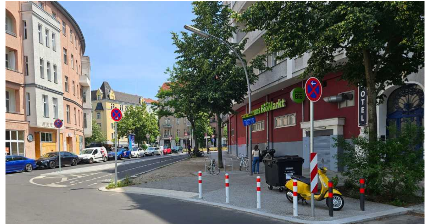
baulich angelegter Anschluss für den Radverkehr Vorbergstraße
