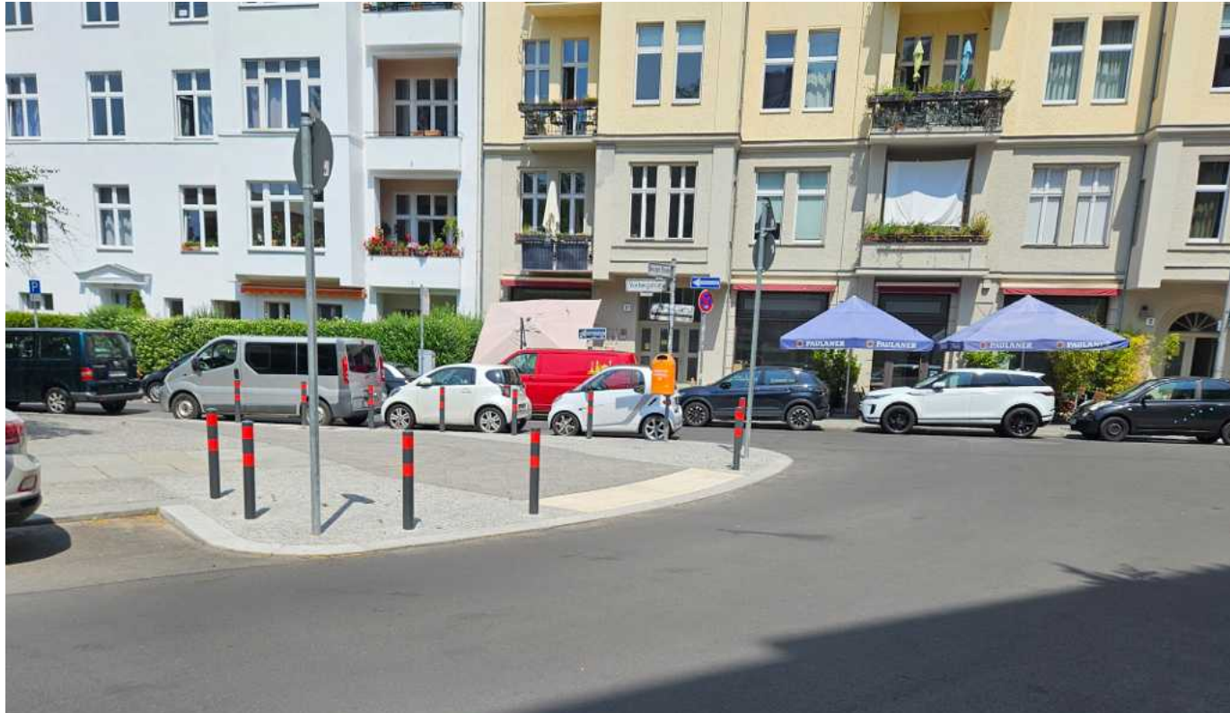
bauliche, einfache Gehwegvorstreckung
