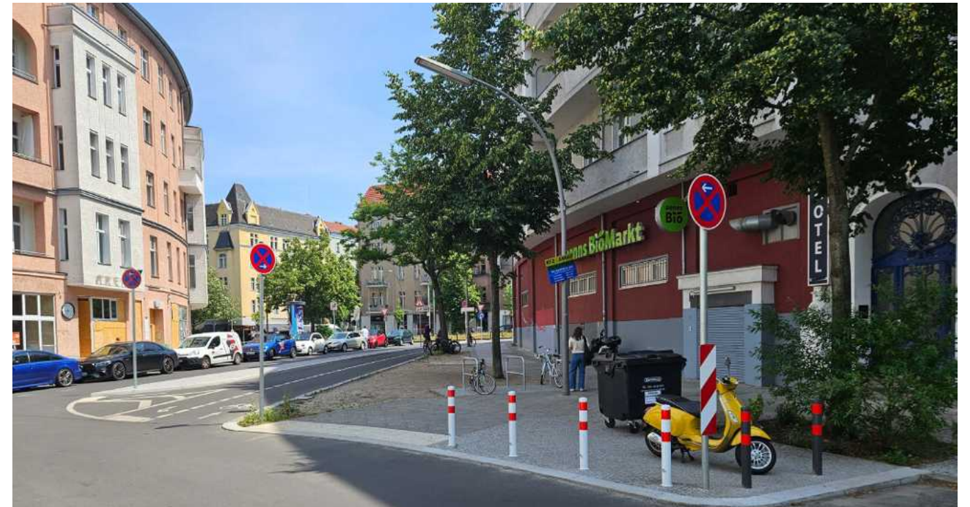
baulich angelegter Anschluss für den Radverkehr Vorbergstraße
